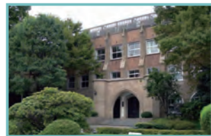
西1号館 1930年建造
