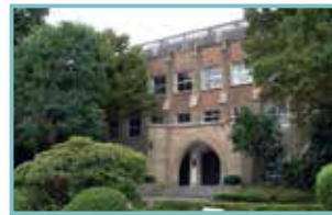
西1号館 1930年建造
