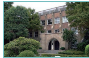
西1号館 1930年建造
