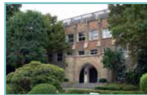
西1号館 1930年建造
