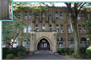
南1号館 1927年建造
