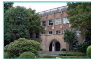
西1号館 1930年建造
