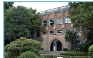
西1号館 1930年建造
